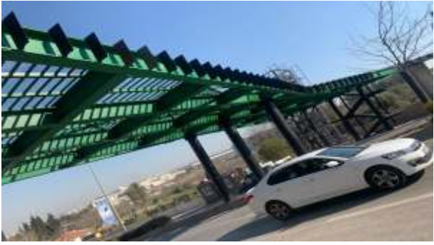
TINAZTEPE YAYA ÜST GEÇİT KÖPRÜSÜ
